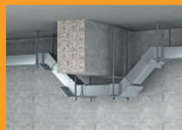
Монтаж на подвесах с переходом под различными углами
