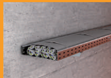
Бандажирование кабельного пучка на несущих системах при монтаже на стене.
