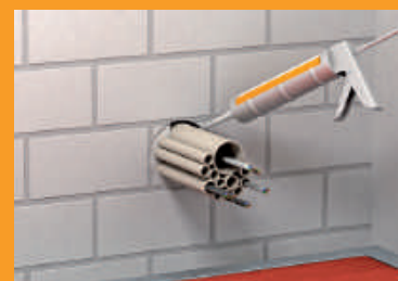
Заполнение концов труб огнестойким защитным средством DSX.
