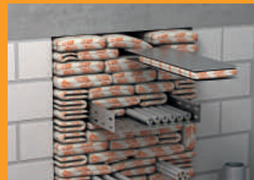
Металлические листы в качестве помощи при монтаже для последнего уровня подушки.
