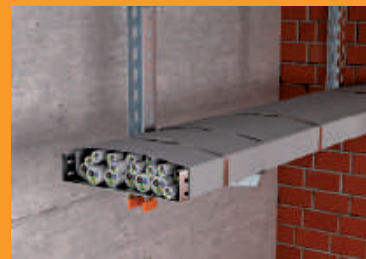
Полное бандажирование подвесной кабельной трассы.
