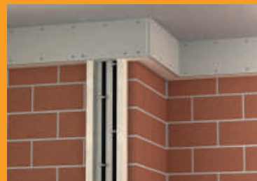
Завершающая обработка поверхности: нанесение краски или декоративных покрытий
